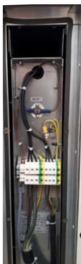
přístup k přípojovací svorkovnici ohřívače – – po sejmutí čelního panelu na obslužné straně jednotky
