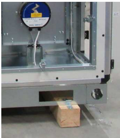
detail přepravního trámu
